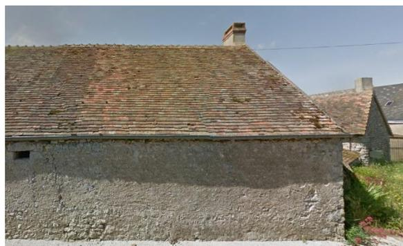
Différentes formes de tuiles existent et dans le Pays de Beauce, seules les tuiles plates et très exceptionnellement les tuiles à emboîtement dites tuiles mécaniques sont mise en œuvre. Les tuiles plates sont de simples rectangles plans, munis de trous pour fixation par clouage.
